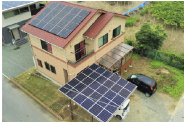
住宅屋根の太陽光発電に、カーポート発電をプラス。
